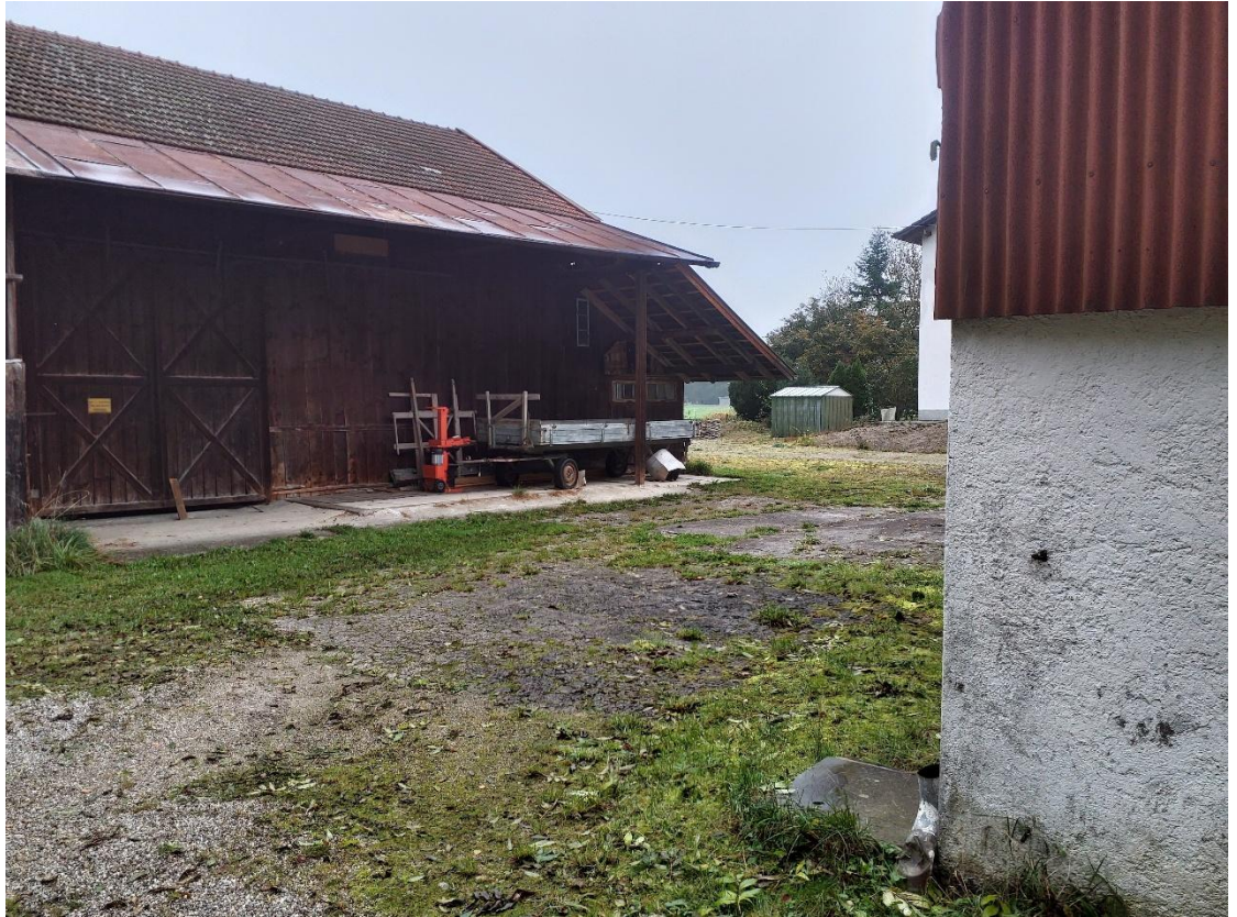
Abb. 10: Bestandsgebäude nördlich des Geltungsbereiches, Aufnahme PV vom 10.10.2025
