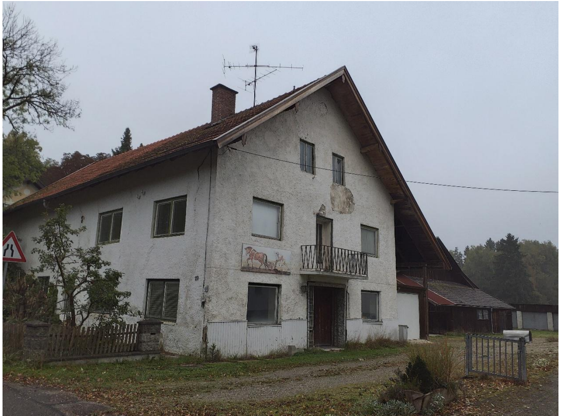
Abb.7: Bestandsgebäude, Aufnahme PV vom 10.10.2025
