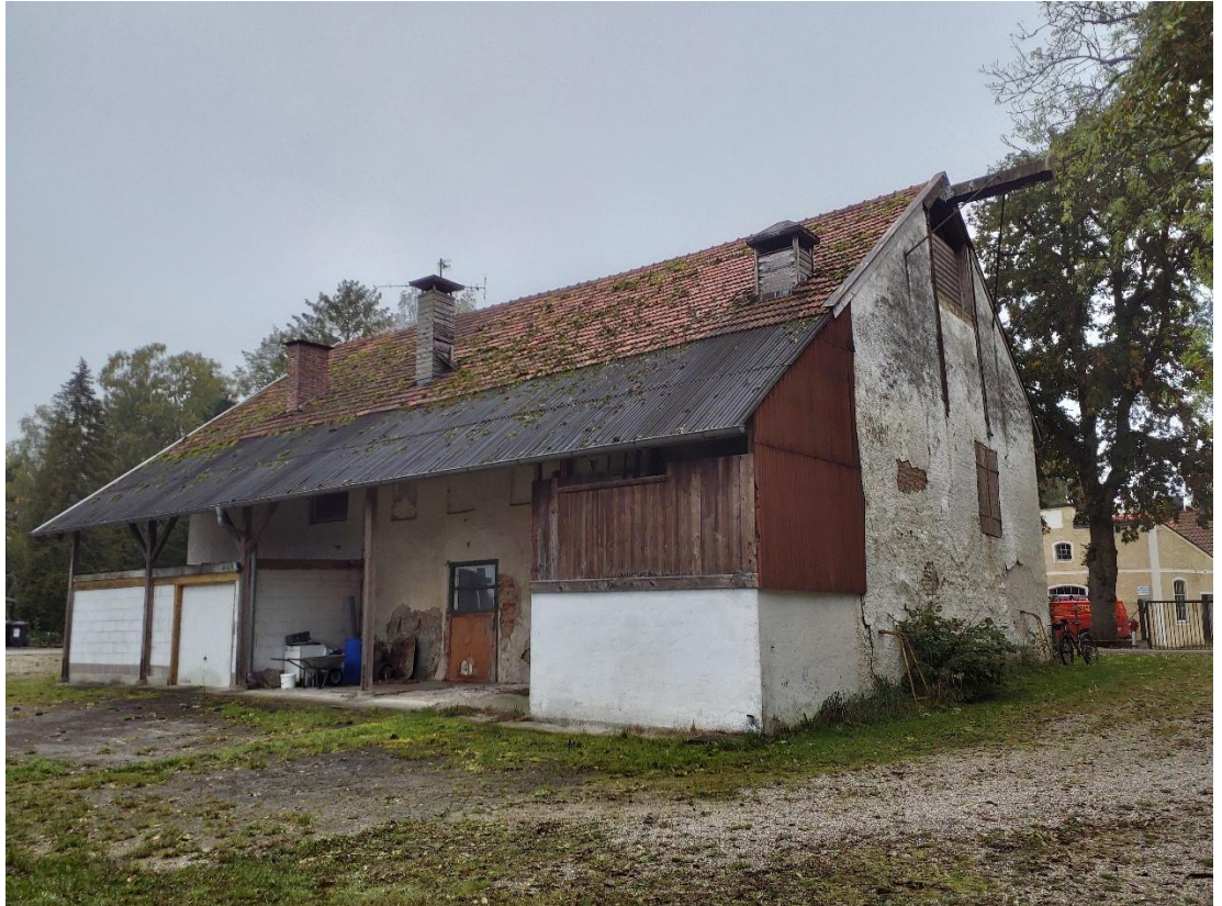
Abb.8: Bestandsgebäude, Aufnahme PV vom 10.10.2025
